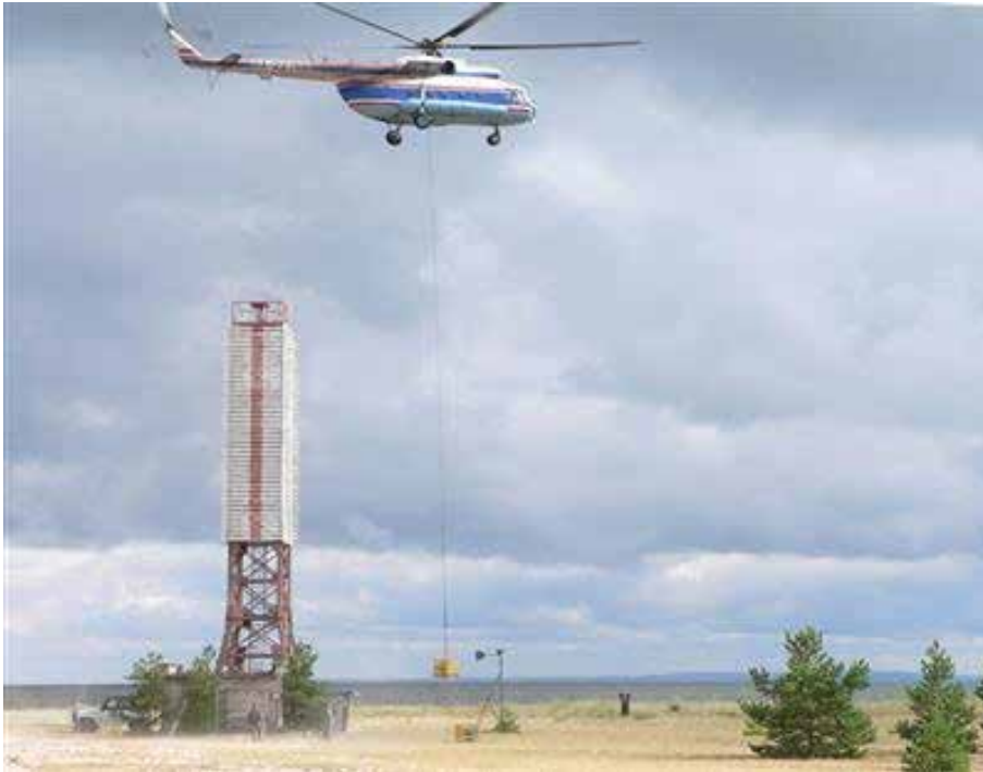
Figur 2: Fjerning av radioaktiv kilde (RTG) som ble brukt som energikilde for fyrlykt.
